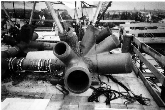
Bild 14. Fußknoten des Fachwerks während der Montage: Vorwärmen des Schweißnahtbereichs
