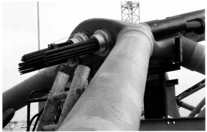
Bild 11. Spannkabel-Verankerung: 31 Litzen, Bruchlast 8215 kN (Aufnahme während des Spanns)
