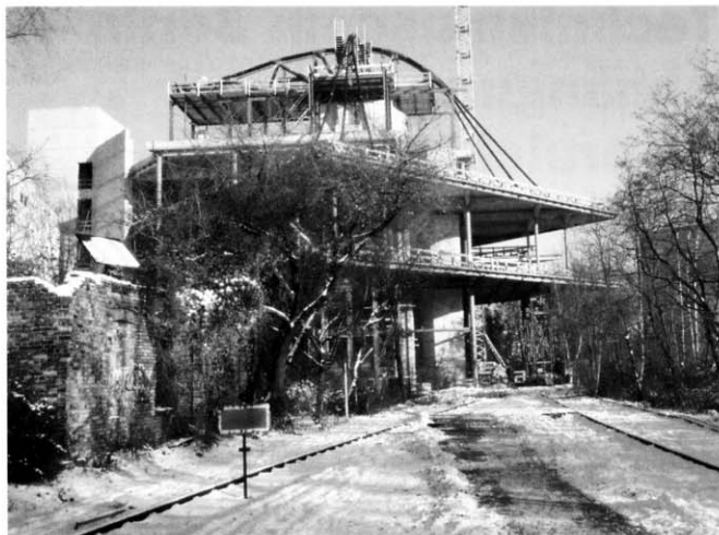
Bild 2. Der Infrastrukturtrakt krägt in Teilbereichen über das Anschlußgleis des Museums
