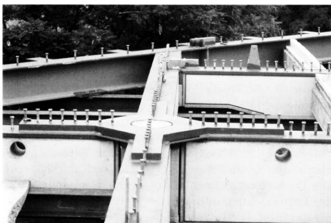
Bild 6. Trägerrost im auskragenden Deckenbereich mit aufgeschweißten Zuglaschen
