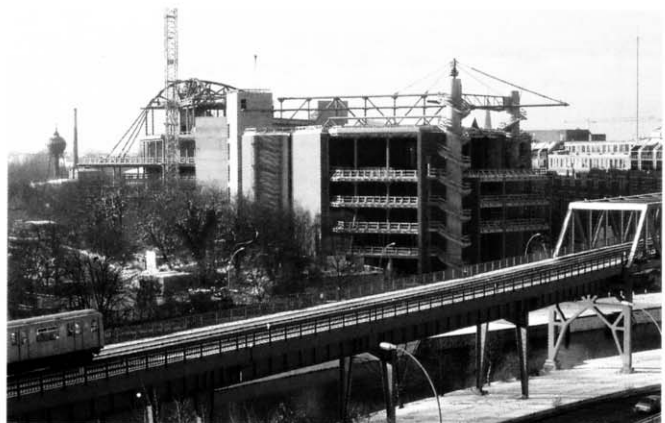
Bild 1. Gesamtansicht des Neubaus von Ost, rechts Ausstellungs- und links Infrastrukturtrakt mit Hängesystem
