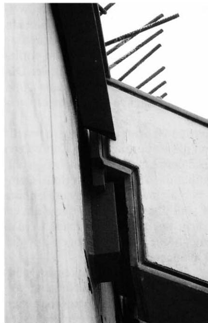
**Bild 9.** Auflager von Hauptträger an Massivwand, Auflagerwinkel 45°
