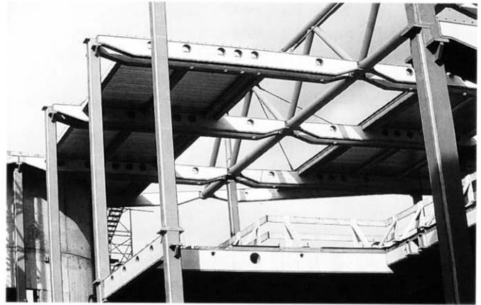
**Bild 11.** Dachöffnung mit Fachwerkträger und anschließenden Hauptträgern
